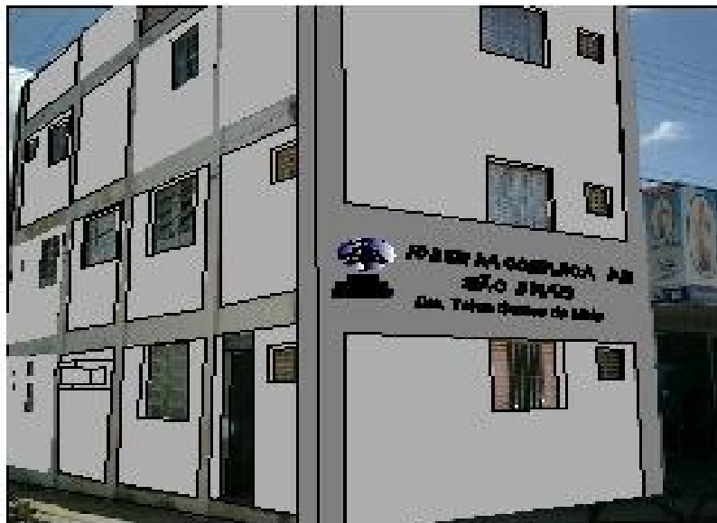
FOTO 01 - Fachada principal do Fórum de São Brás com sinalização centralizada na platibanda superior.
