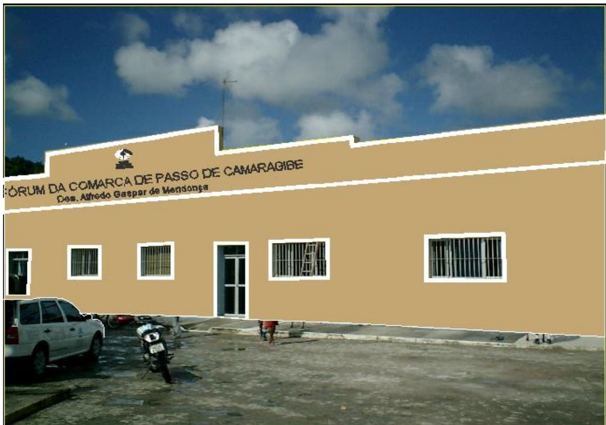
FOTO 01 - Fachada principal do Fórum de Passo de Camaragibe com sinalização centralizada na platibanda superior.
